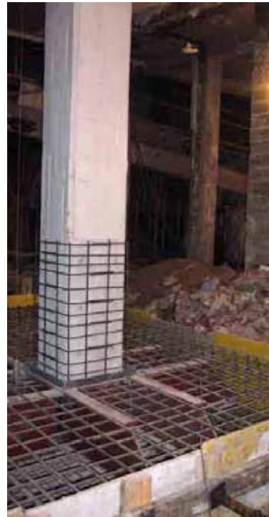
Rehabilitación de Edificio de 80 Viviendas en Paseo de Recoletos, 18 - Madrid
