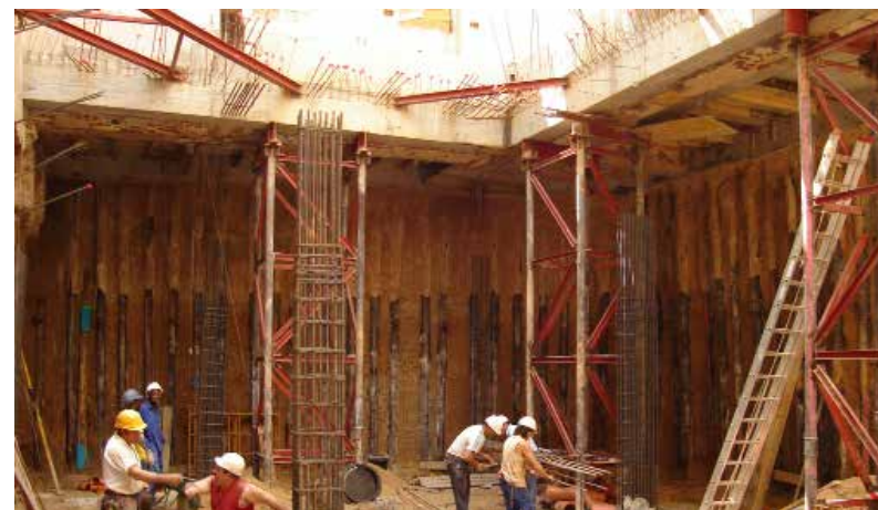
Rehabilitación y Ampliación Edificio para 6 Viviendas C/Zurbano, 55 - Madrid
