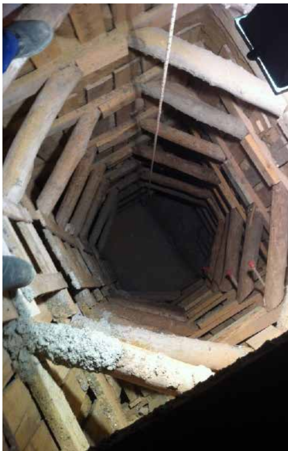
Rehabilitación Integral de 24 Viviendas C/Génova, 5 - Madrid
