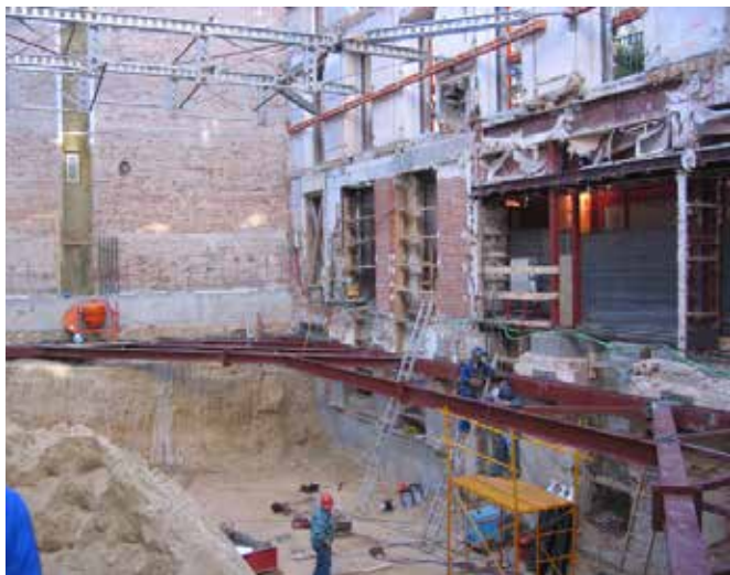
Rehabilitación y Edificación de 16 Viviendas, locales y garaje C/ Claudio Coello, 72 - Madrid
