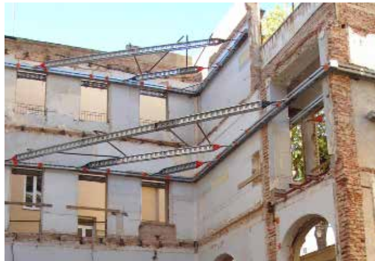
Rehabilitación y Ampliación Edificio para 6 Viviendas C/Zurbano, 55 - Madrid
