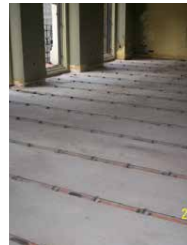
Reforma de Edificio para 14 Viviendas C/Salustiano Olózaga, 11 - Madrid
