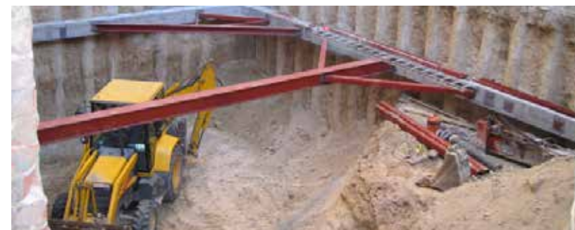
Rehabilitación de Edificio y Garaje C/Fortuny, 1 - Madrid
