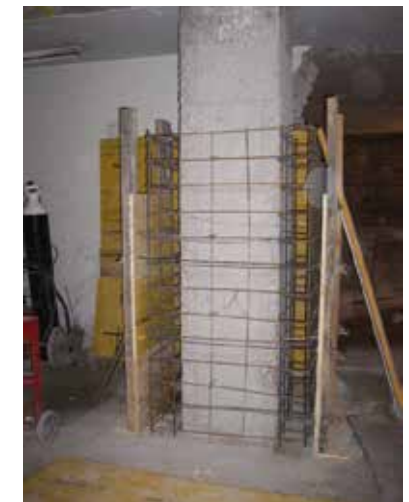
Rehabilitación de Edificio para 53 Viviendas en C/ Almagro, 34 - Madrid
