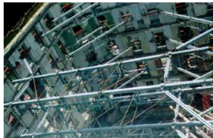
Rehabilitación y Edificación de 16 Viviendas, Locales y garaje C/Claudio Coello, 72 - Madrid Ejecución de Estabilizador de Fachada
