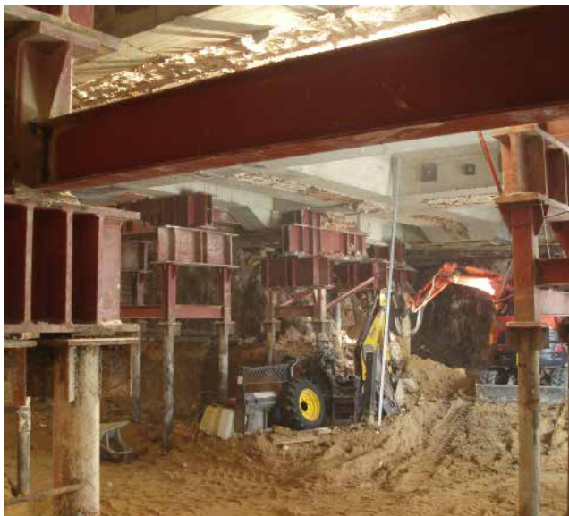
Rehabilitación de Edificio (1ª Fase) C/Villanueva, 4 - Madrid
