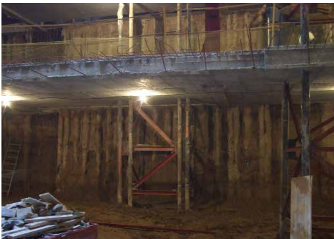
Rehabilitación de Edificio (1º Fase) C/Villanueva, 4 - Madrid
