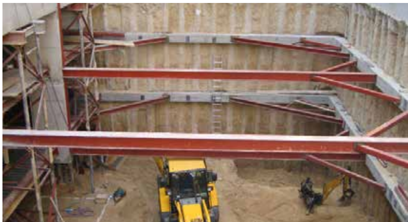
Rehabilitación de Edificio y Garaje C/Fortuny, 1 - Madrid
