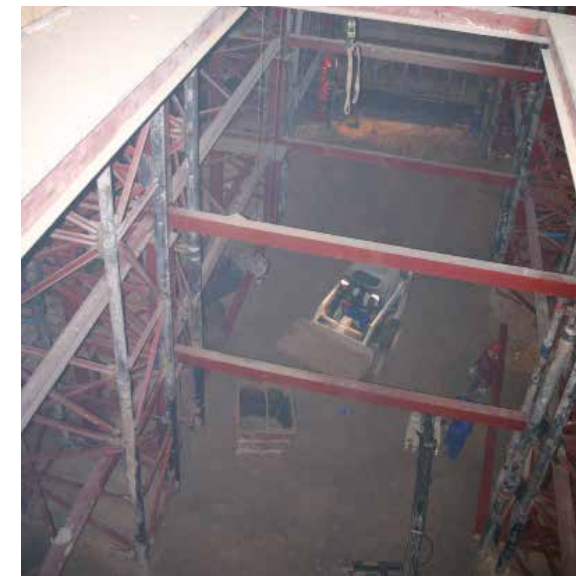
Rehabilitación de Edificio de 26 Viviendas en Paseo de la Castellana, 68 - Madrid
