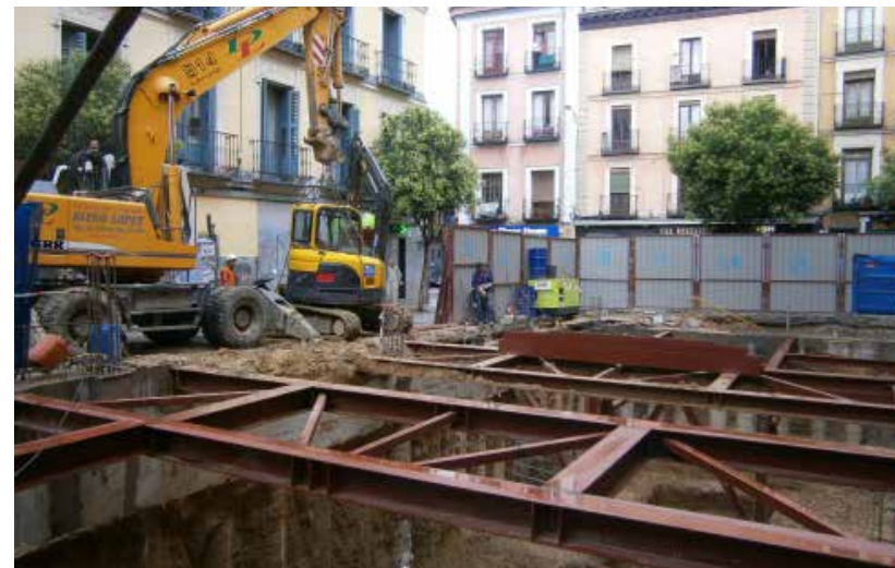
Obra Civil y Estructura Parking Robotizado C/ Fuencarral esq C/ Sta. Barbara - Madrid
