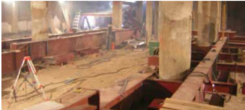
Rehabilitación de Edificio de 26 Viviendas en Paseo de la Castellana, 68 - Madrid
