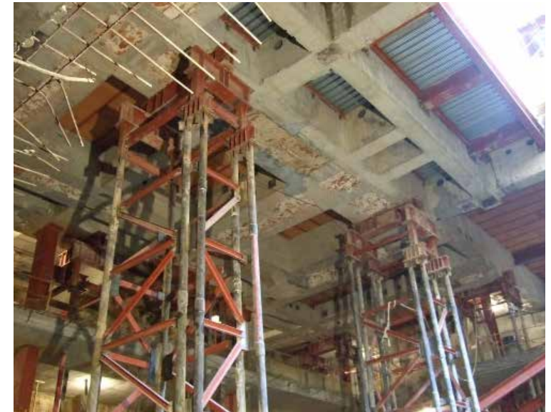
Rehabilitación de Edificio (1º Fase) C/Villanueva, 4 - Madrid
