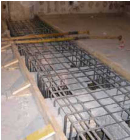
Rehabilitación de Edificio para 53 Viviendas en C/ Almagro, 34 - Madrid
