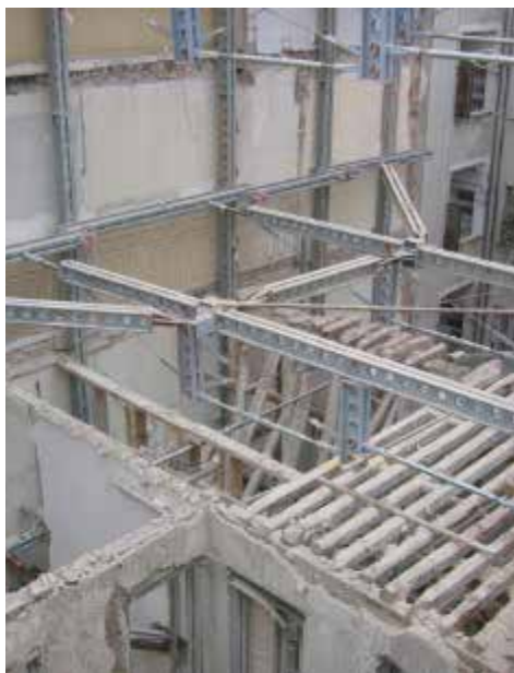
Rehabilitación y Edificación de 16 Viviendas, Locales y garaje C/Claudio Coello, 72 - Madrid Ejecución de Estabilizador de Fachada
