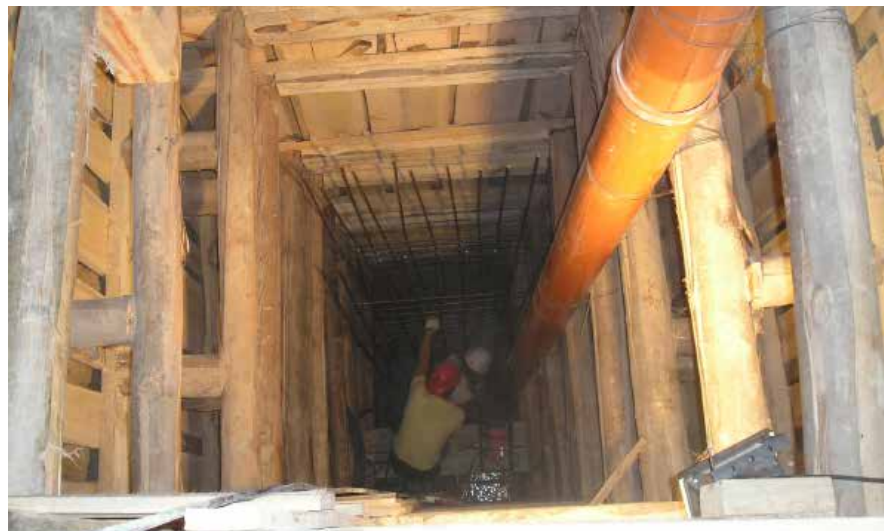
Rehabilitación Integral de 24 Viviendas C/Génova, 5 - Madrid
