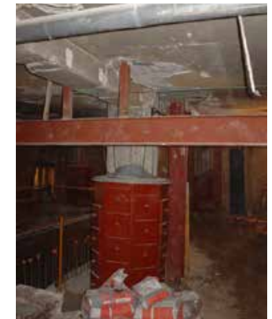
Rehabilitación Edificio de 26 Viviendas P. de la Castellana, 68 - Madrid
