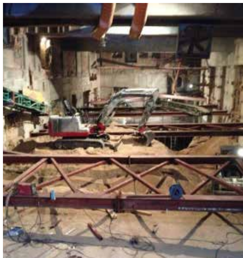
Rehabilitación Integral de 24 Viviendas C/Génova, 5 - Madrid
