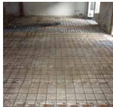
Rehabilitación Integral de 24 Viviendas C/Génova, 5 - Madrid
