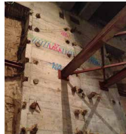
Rehabilitación Integral de 24 Viviendas C/Génova, 5 - Madrid
