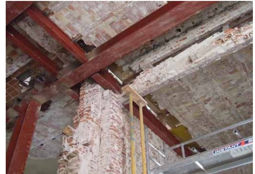
Rehabilitación de Edificio (1º Fase) C/Villanueva, 4 - Madrid
