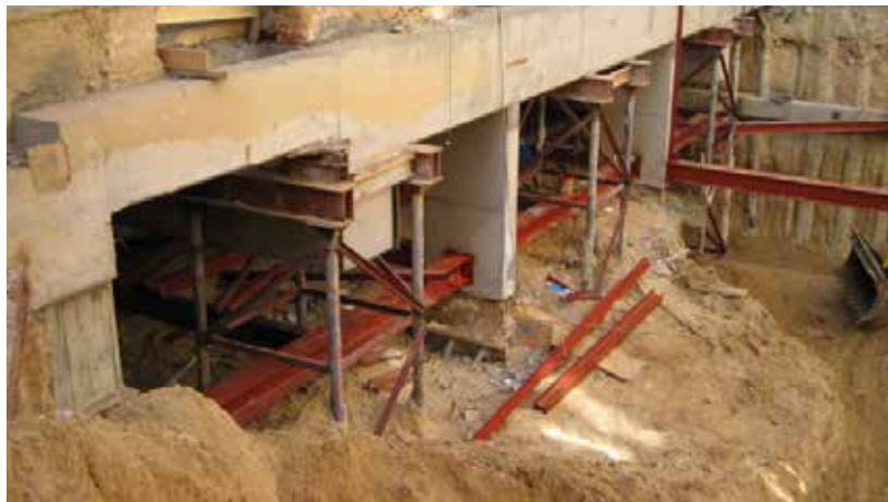
Rehabilitación de Edificio y Garaje C/Fortuny, 1 - Madrid
