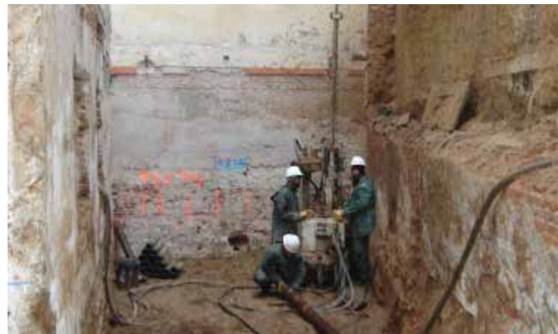
Rehabilitación y Ampliación Edificio para 6 Viviendas C/Zurbano, 55 - Madrid
