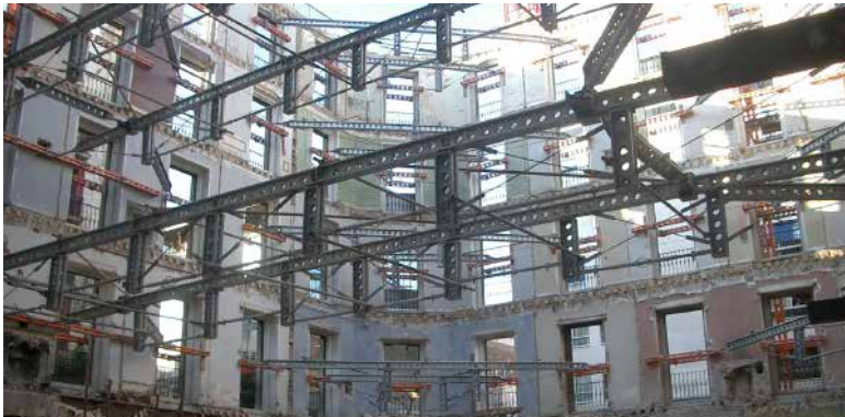
Rehabilitación y Edificación de 16 Viviendas, locales y garaje C/Claudio Coello, 72 - Madrid
